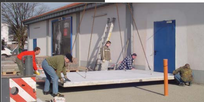
Bodenplattenmontage
